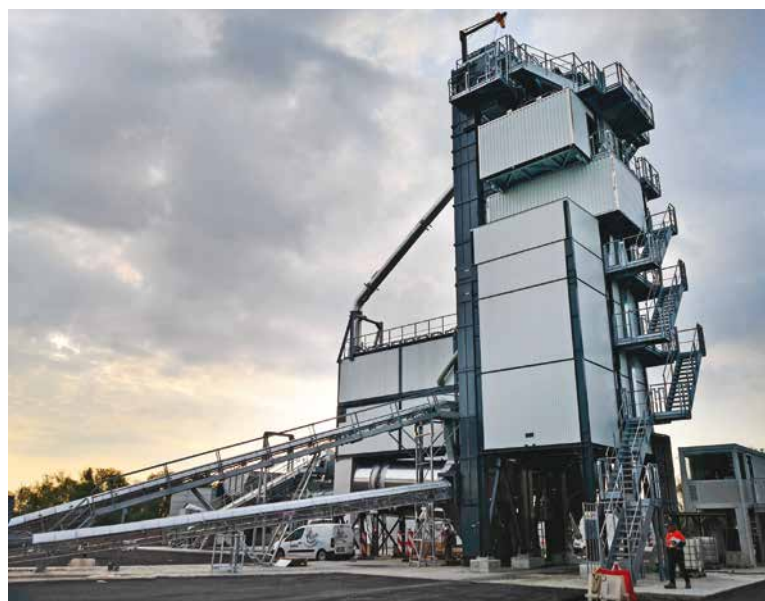
9. Dettaglio della doppia linea dell'alimentazione del fresato
