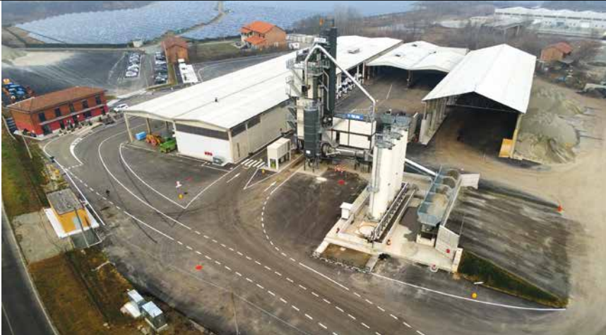
2. Veduta del cantiere Tra.Ma., Azienda torinese con base operativa a Torrazza Piemonte
